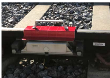
BILD 2, Beläggingsdon över axelräknarhuvud
